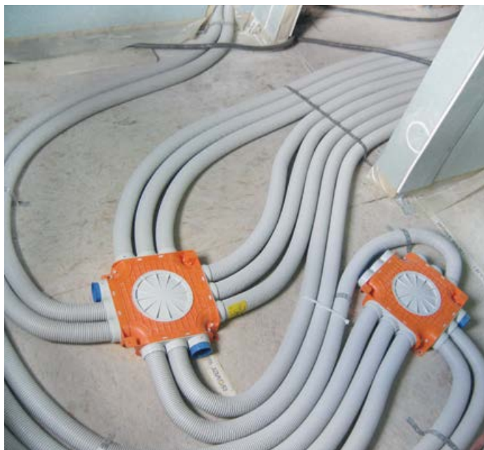
Instalacja R-VENT Flex na stropie przygotowana do ukrycia w konstrukcji wylewki
