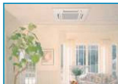
Klimatyzator kasetonowy z nawiewem 4-stronnym
